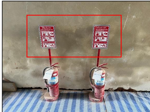
ภาพที่ 42 ถังดับเพลิงและป้ายแนะนำการใช้งาน
