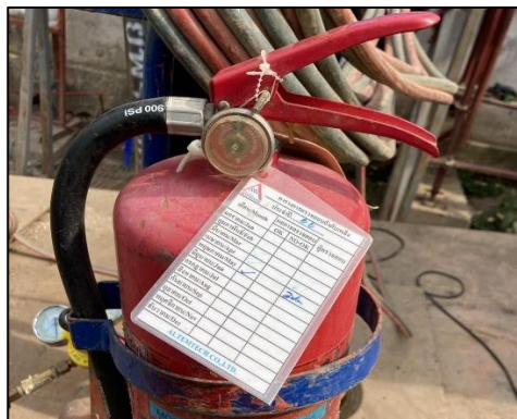
ภาพที่ 43 ตรวจสอบถังดับเพลิง
