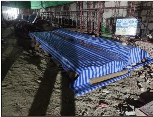
ภาพที่ 9 ผ้าใบคลุมกองวัสดุก่อสร้าง
