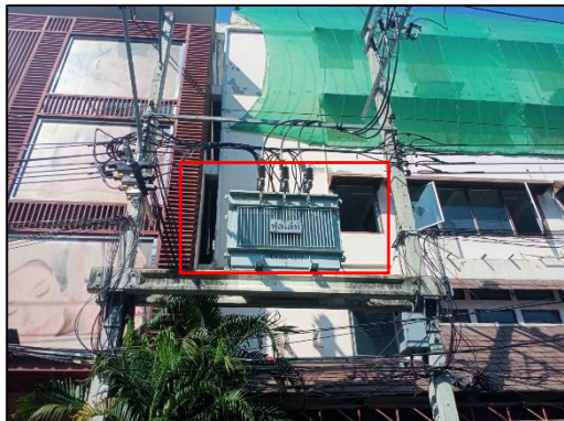
ภาพที่ 50 หม้อแปลงไฟฟ้า
