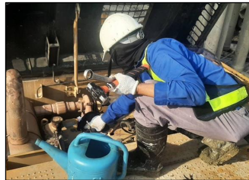
ภาพที่ 20 ใช้น้ำมันหล่อลื่นลดการเสียดสี
