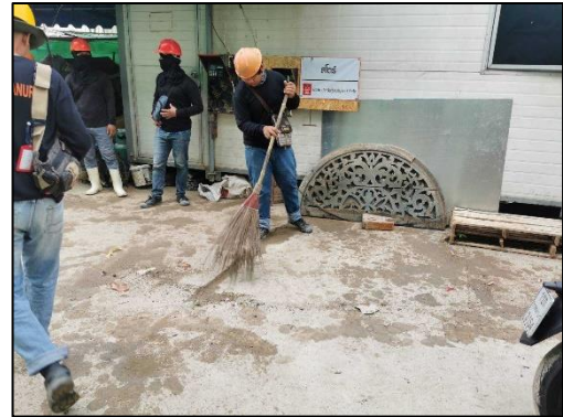
ภาพที่ 6 กวาดฝุ่นละอองและตะกอนภายในหลังการฉีดพรมน้ำ (ต่อ)
