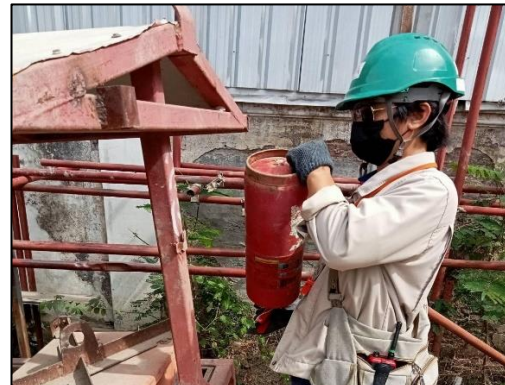
ภาพที่ 43 ตรวจสอบถังดับเพลิง
