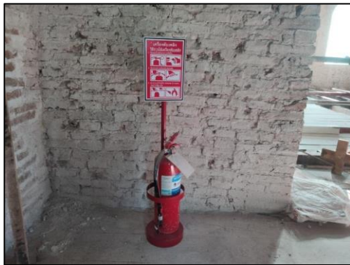
ภาพที่ 42 ถังดับเพลิงและป้ายแนะนำการใช้งาน
