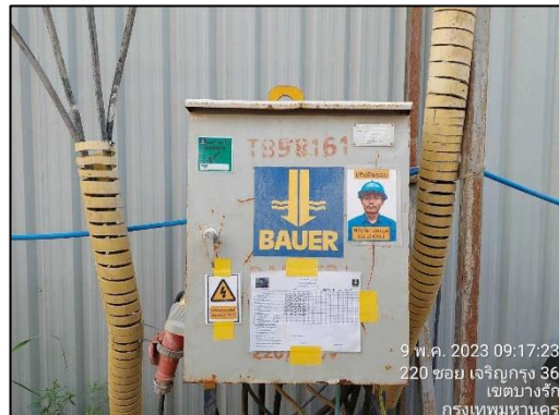
ภาพที่ 51 ติดตั้งแผงควบคุมไฟฟ้าและเครื่องตัดกระแสไฟฟ้าพร้อมวิธีตรวจดูแผงไฟฟ้า
